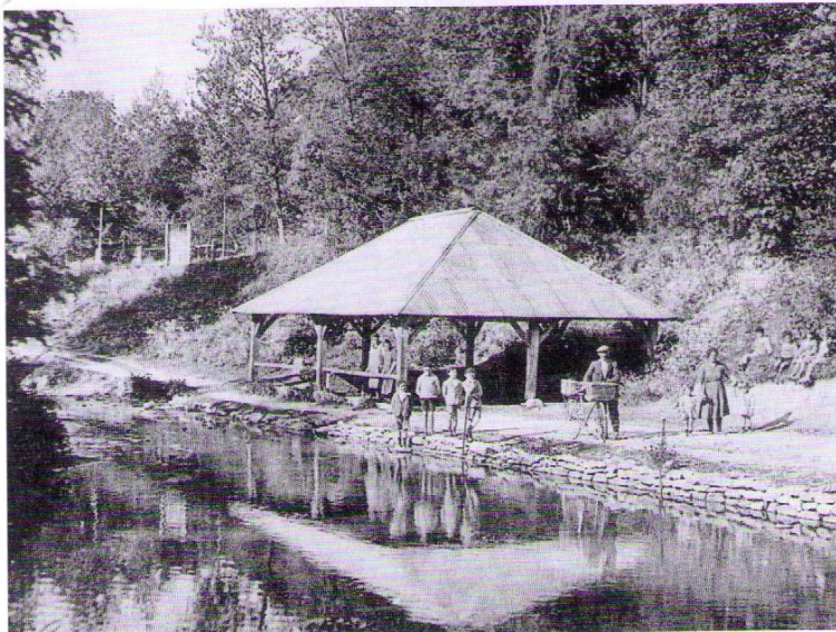
Tavaux-Ponséricourt : le lavoir V
