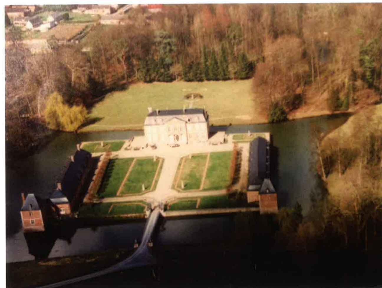
Bosmont 1997, vue aérienne du château (A. Nice 1997).
